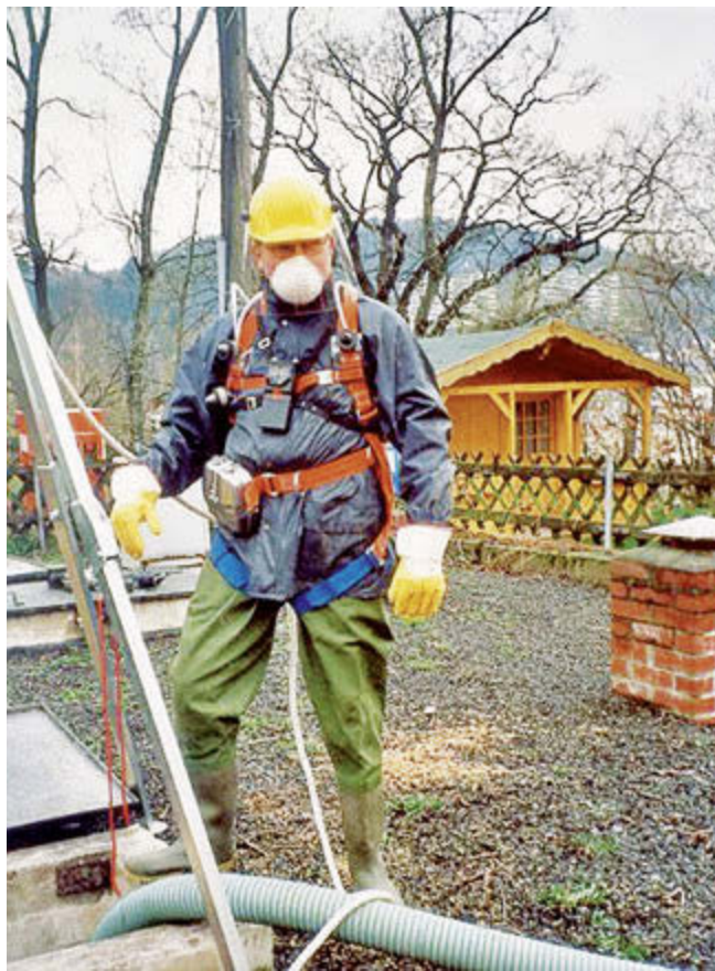
Abb. 6: Abwasserentsorger vor dem Einstieg in den Schacht zu Reinigungsarbeiten, allerdings mit mangelhaftem Handschutz
