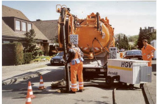
Abb. 1: Untersuchungen der Bakterienbelastung am Schacht bei Einsatz eines Prototyps der Luftschleierabspernung durch Horizontalgebläse
