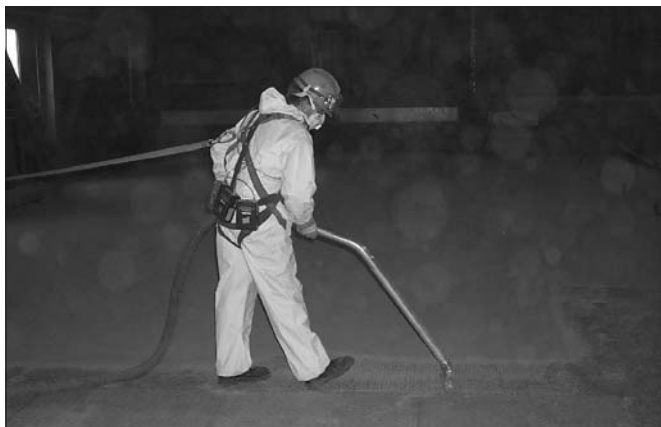
Bild 5. Reinigungstätigkeit im Müllbunker mit Staubsauger.
