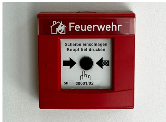
Abb. 13: Handfeuermelder Brandmeldeanlage
