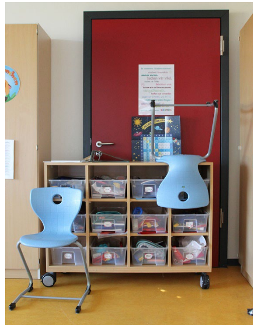
Abb. 2: Versperrter zweiter Rettungsweg
