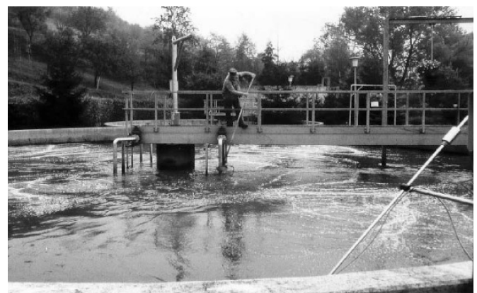
Bild 3. Reinigungsarbeiten am Belebtschlammbecken.
