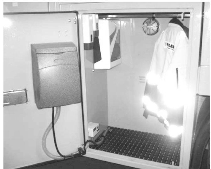
Bild 5. Hygienekammer am Kanalspülfahrzeug.
