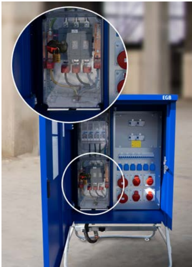
Abb. 9 Baustromverteiler mit Festanschluss
