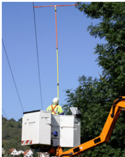
Abb. 5 Abstandsermittlung vom Korb der Hubarbeitsbühne aus
