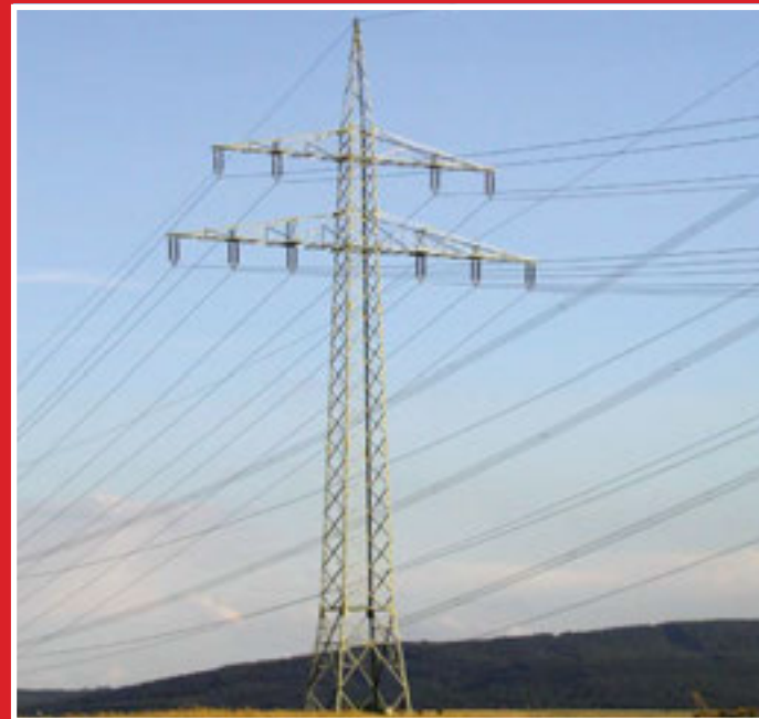
Masthöhe ca. 25 – 30 m
