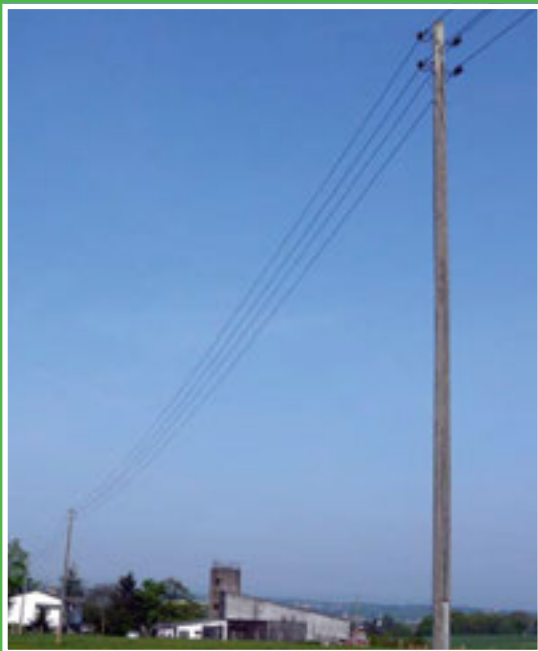
Masthöhe ca. 8 – 12 m Niederspannungs- freileitung
