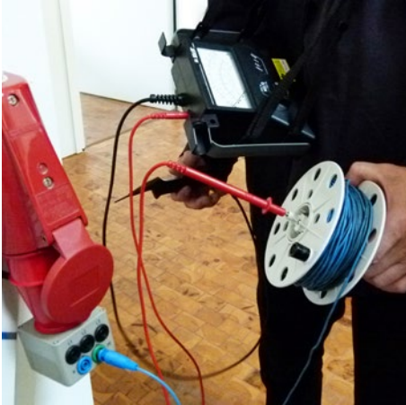
Abb. 8 Messung der niederohmigen Schutzleiterverbindung
