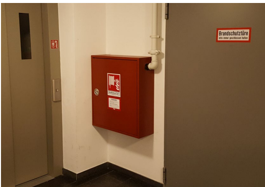
Abb. 66 Wandhydrantenschrank
