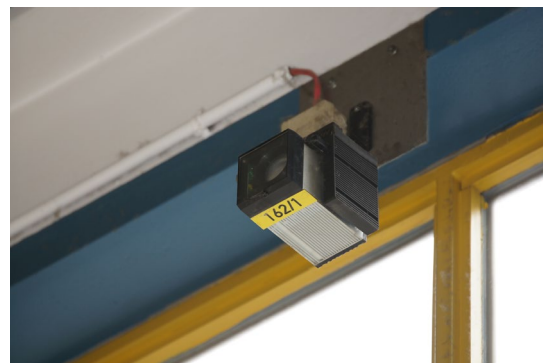
Abb. 35 Lichtschraken-Rauchmelder
