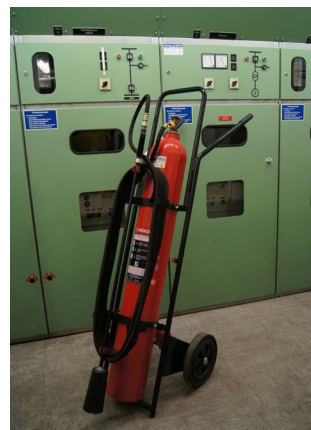
Abb. 45 Fahrbarer Kohlendioxid-Feuerlöscher
