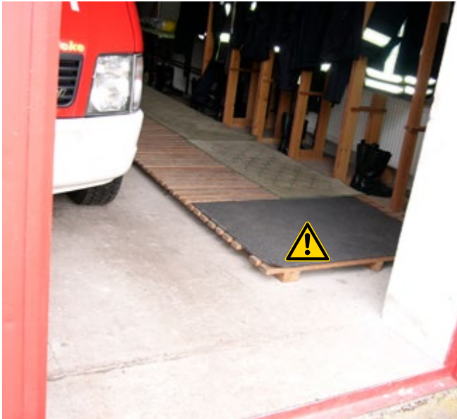
Bild 17 Diese Konstruktion birgt Umknick- oder Stolpergefahr
