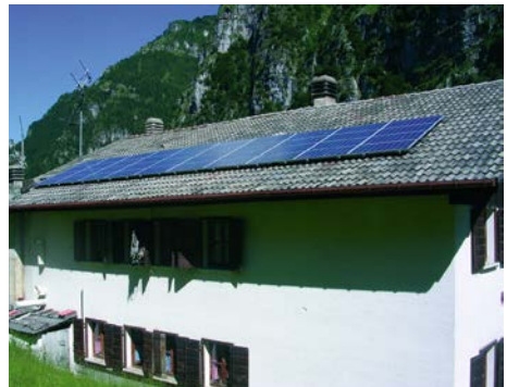
Abb. 13 Hier versorgt das Photovoltaik-System eine Hütte mit elektrischer Energie. Dabei ist von außen nicht erkennbar, ob es sich im Gebäude um ein reines Gleichstromnetz handelt oder ein Wechselrichter eingesetzt wird.
