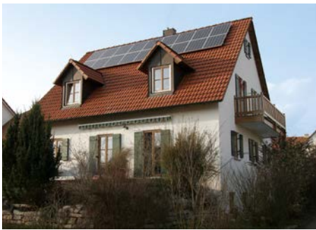
Abb. 6 PV-Anlage auf einem freistehenden Gebäude.
