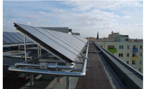
Abb. 4 Solarthermie-Anlage
