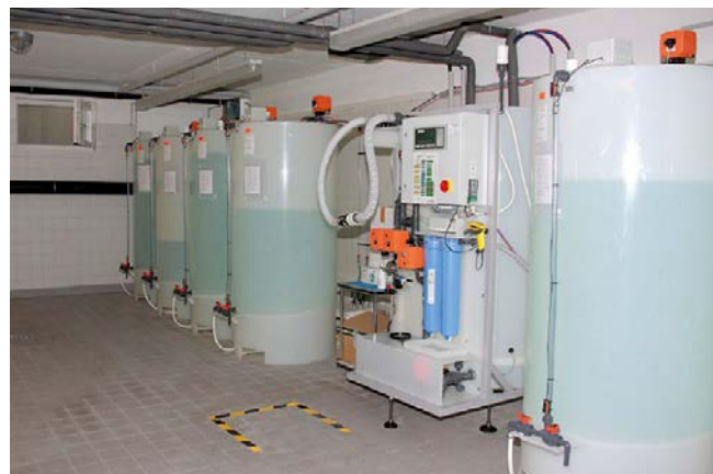
Bild 17 Konzentratmischanlage
