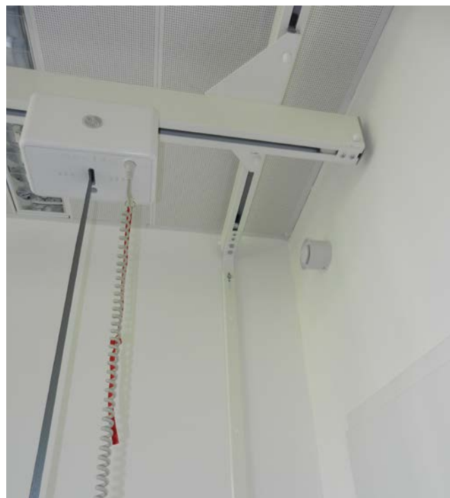
Bild 3 Portalmontage eines Patienten-Deckenlifters
