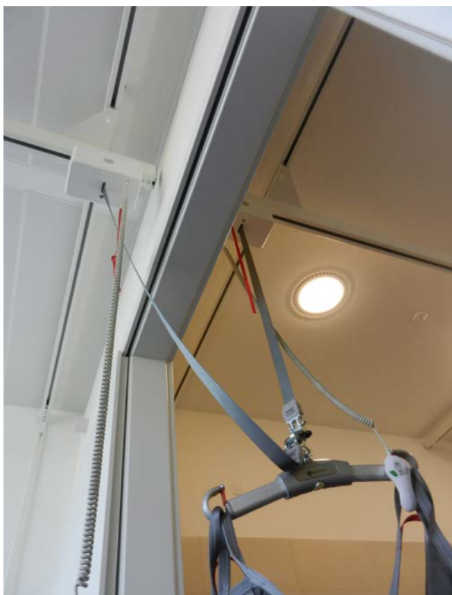
Bild 5 Deckenliftsystem mit Umhängemöglichkeit des Liftertuches am Türsturz
