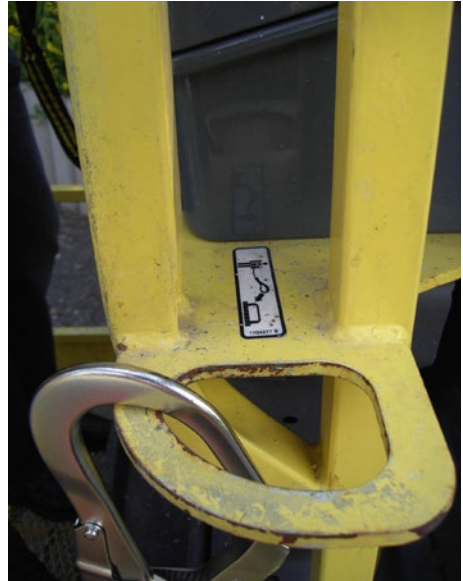
Bild 9-4 Anschlagpunkte
