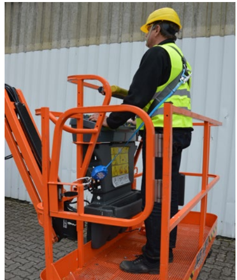
Bild 9-3 Einsatz von PSA gegen Absturz
