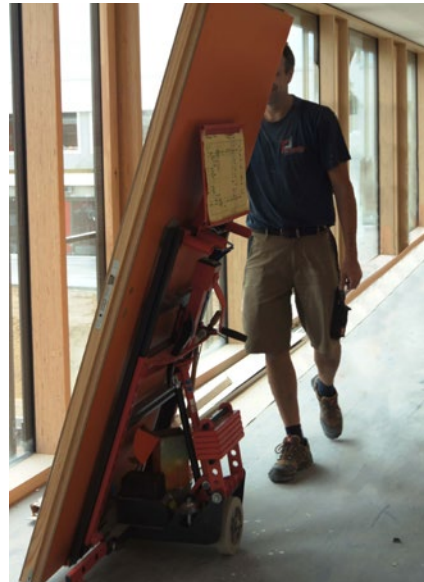
Abb. 74 Durch Hebe-/Transportroller bzw. Treppenroller entfällt manuelles Tragen
