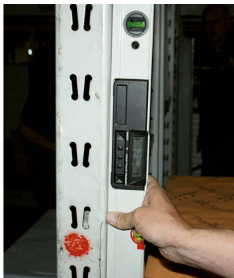
Abb. 10 Messung der Schiefstellung mit digitaler Wasserwaage
