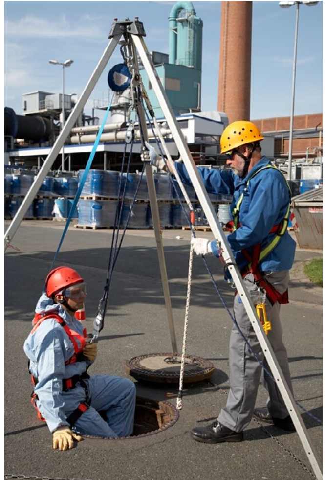
Abb. 9-4 Einstieg in einen Kanal mit erforderlicher Schutzausrüstung
