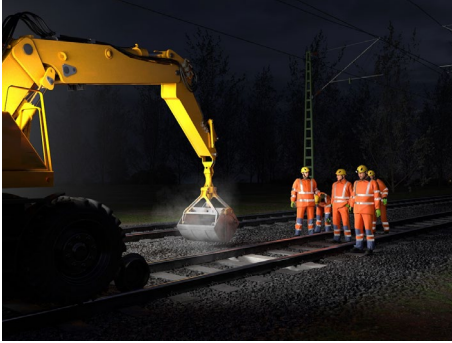
Abb. 22 Gleisoberbauarbeiten: Empfehlung Warnkleidung Klasse 3
