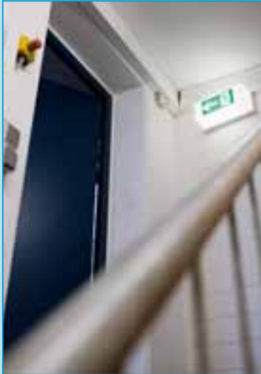
Gekennzeichneter Rettungsweg im Beschäftigtenbereich
