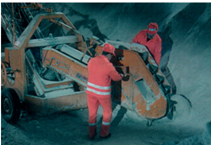
Salzladeförderband mit Becherwerk
