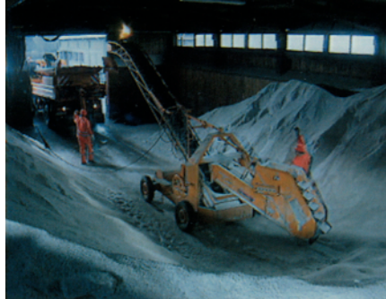
Beladen eines Winterdienstfahrzeuges mit dem Förderband
