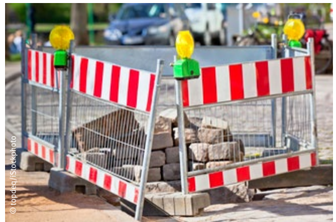
Abb.3 Baustelle mit Baken und Lichtzeichen gesichert
