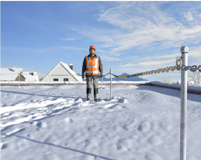
Abb. 19 Absperrung des Gefahrenbereichs mit einer Kette
