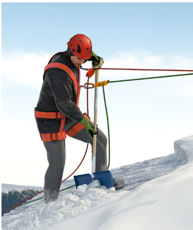
Abb. 5 Schneeräumung mit Schneeschieber
