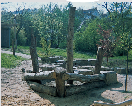
Haltbarkeit der Hölzer im Erdbereich durch Feuchtigkeit beeinflusst
