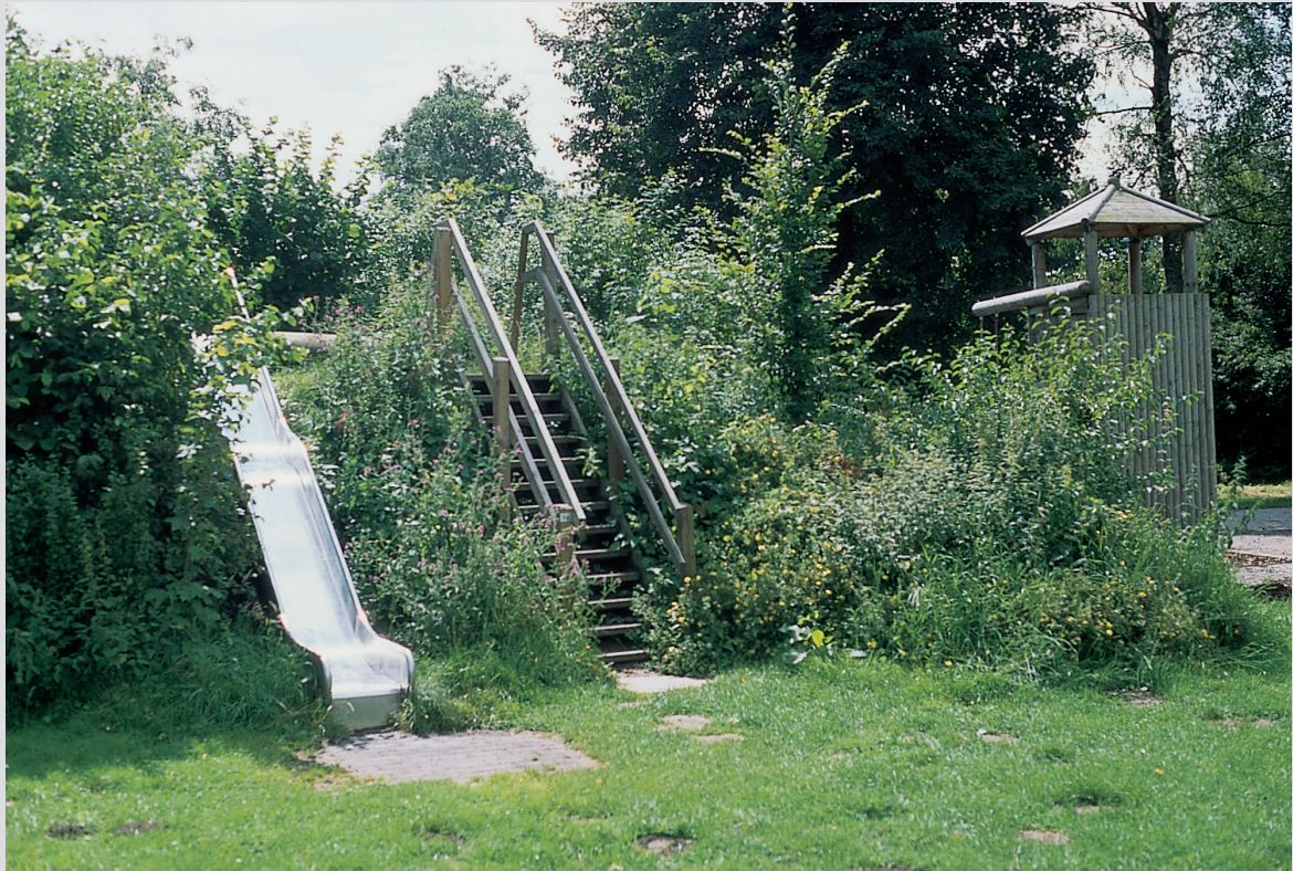
Ausreichend befestigte Rutsche (DIN EN 1176), ungeeigneter Auslaufbereich
