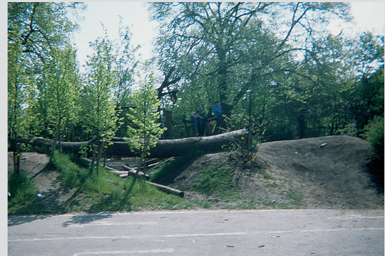
Stoßdämpfender Untergrund unter „Brücke“ mangelhaft (Baumstämme)
