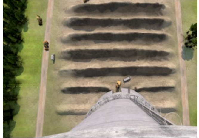
Abb. 119 Fallbett für eine Schornsteinsprengung
