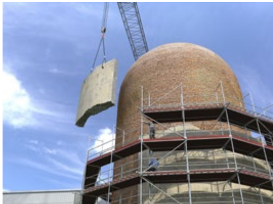
Abb. 109 Rückbau einer Gebäudehülle
