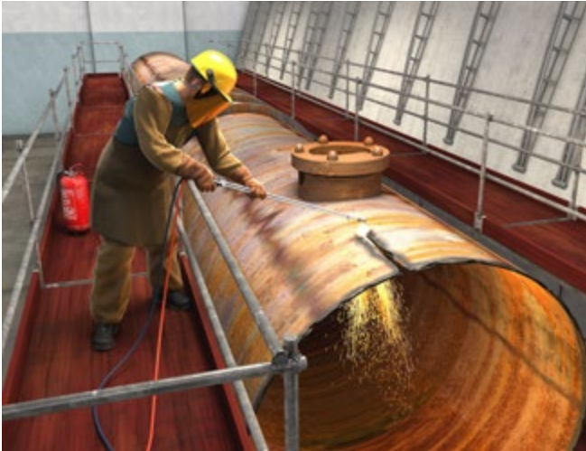
Abb. 114 Rückbau Rohranlage
