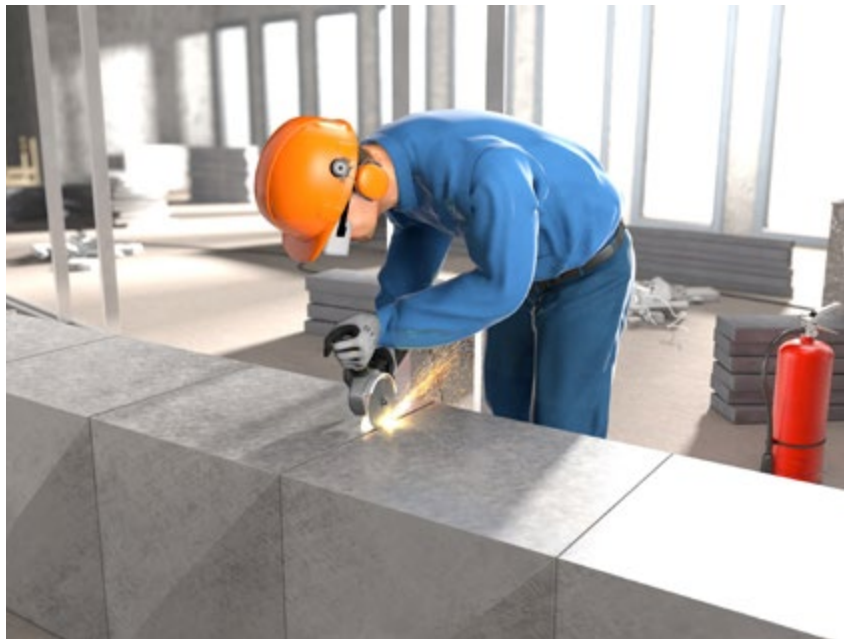
Abb 27 Persönliche Schutzausrüstung beim Trennschleifen von Metall
