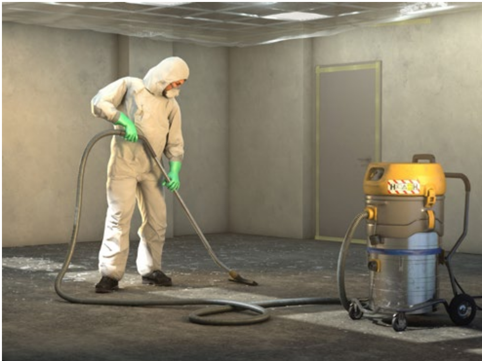
Abb. 19 Industriestaubsauger Staub- klasse H zur Reinigung einsetzen
