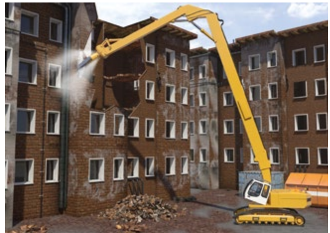
Abb. 84 Abbruchbagger mit Longfrontausrüstung
