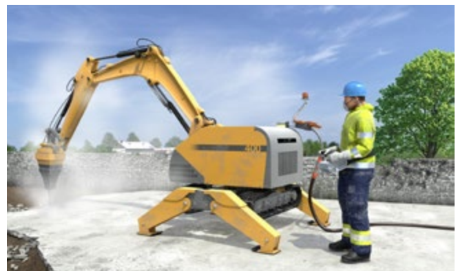
Abb. 102 ferngesteuerte Abbruchmaschine statt handgeführte Werkzeuge
