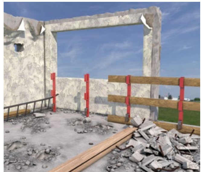
Abb. 111 Absturzsicherung vor der Demontage anbringen
