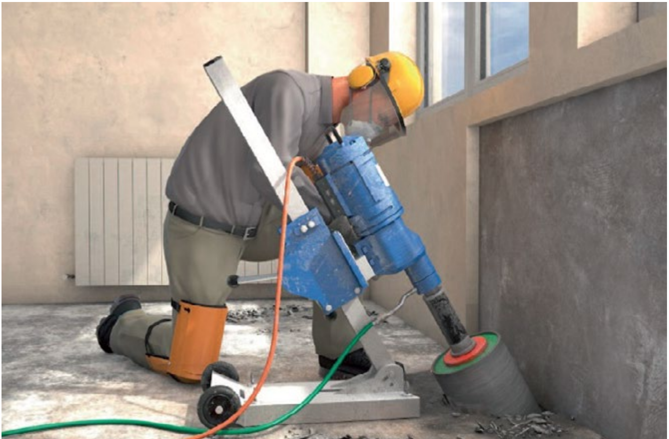
Abb. 40 PSA bei Betonbohrarbeiten
