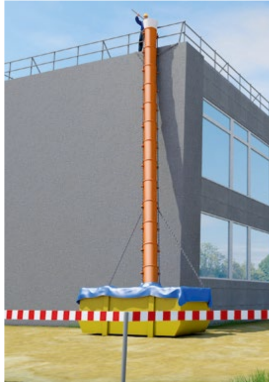
Abb. 103 Absturzsicherung an Schuttrutsche
