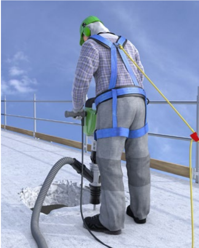
Abb. 101 Abbrucharbeiten mit PSaG
