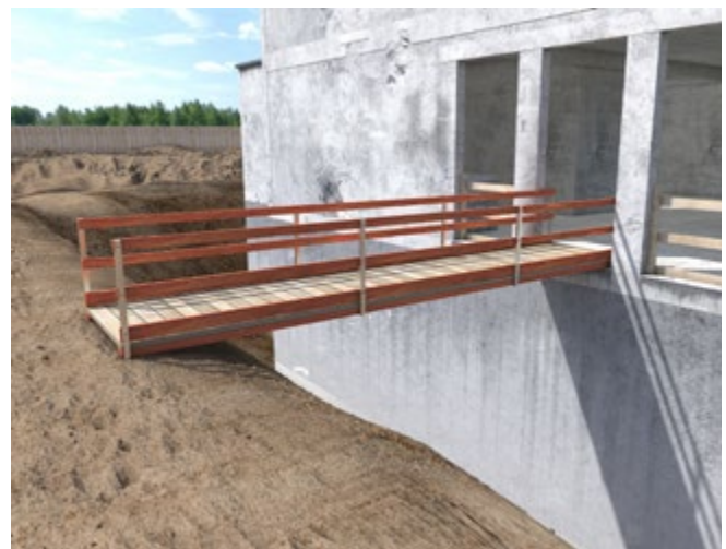
Abb. 6 Laufsteg mit Seitenschutz als Verkehrsweg
