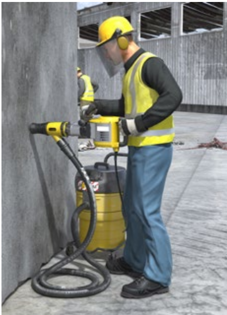
Abb 26 Persönliche Schutzausrüstung bei Arbeiten mit dem Bohrhammer
