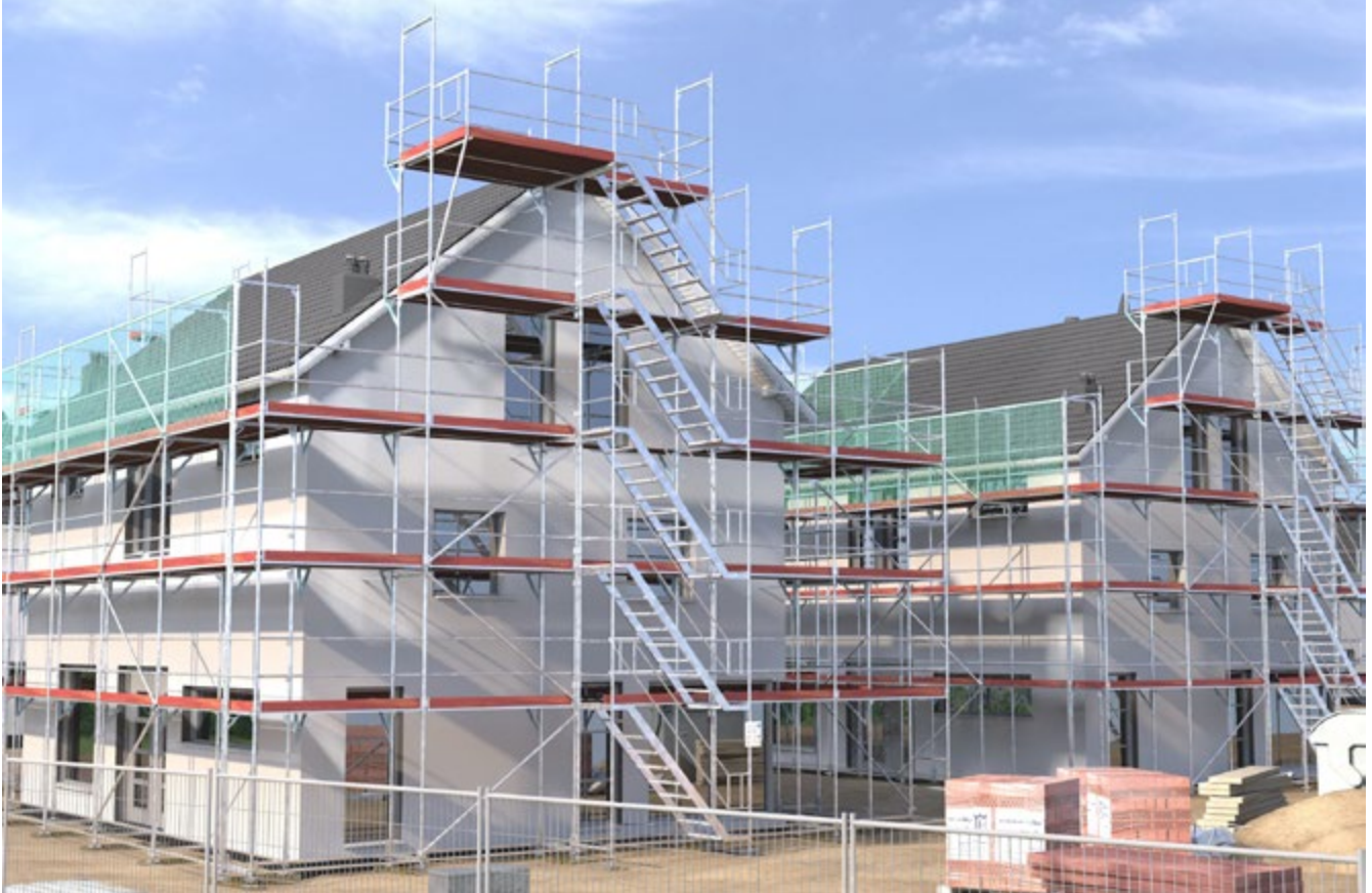
Abb. 53 fachgerechter Zugang zum Gerüst
