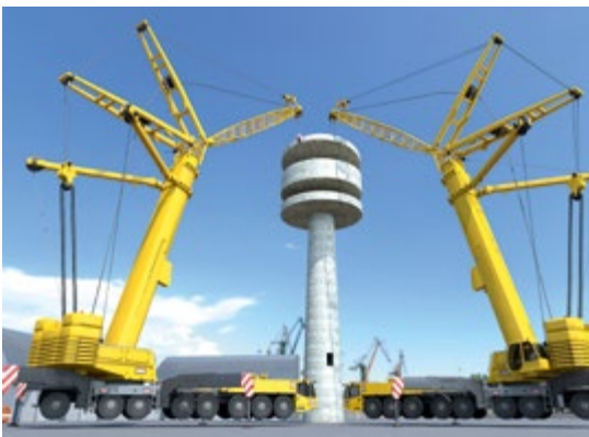
Abb. 108 Demontage eines Turms aus Stahlbeton
