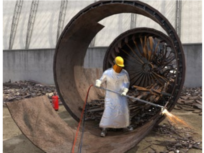
Abb. 115 Brennschneidarbeiten
