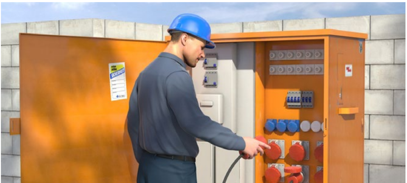
Abb. 20 Baustromverteiler zur sicheren Stromversorgung einer Baustelle
