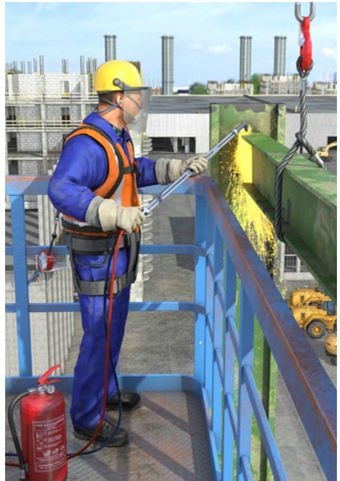
Abb. 25 Schneidbrennarbeiten
