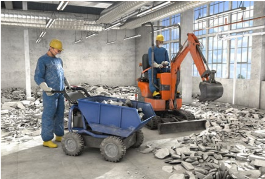
Abb. 92 Beräumung von Schutt
