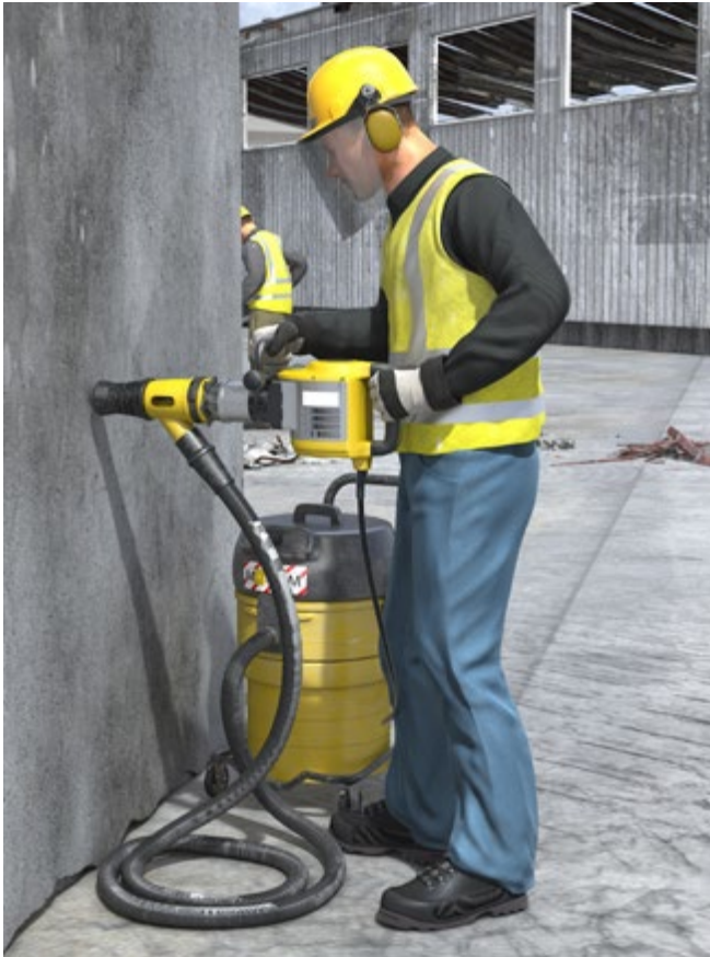
Abb. 85 Bohrhammer mit Absaugung
