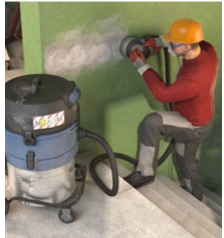
Abb. 10 Bau-Entstauber (z. B. Filterklasse M)
