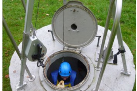
Abb. 23 Höhensicherungsgerät mit Rettungshubfunktion
