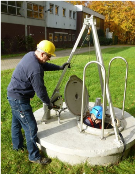
Abb. 27 Rettung mittels Hörsicherungsgerät mit Rettungshubfunktion
