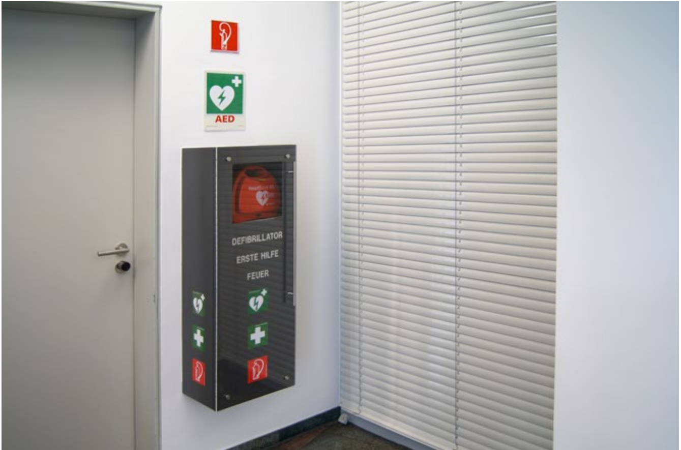
Abb. 2 Wandschrank mit Defibrillator, Erste-Hilfe-Material und Feuerlöscher
