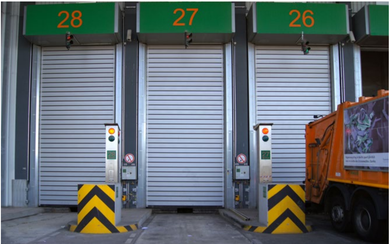
Abb. 10 Gesicherte Kippstelle
