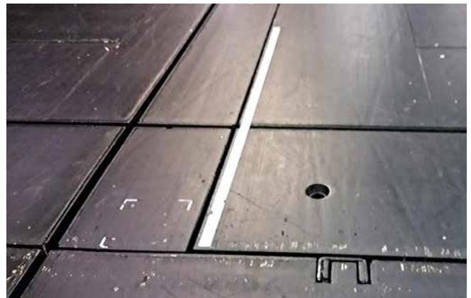
Akute und chronische Verletzungsgefahren durch fehlenden Schwingboden und (links) unterschiedliche Härtegrade sowie (rechts) Aufsplitterung und Drehbühnenspalt
