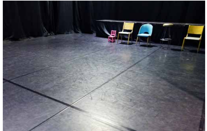
Oberflächlich in Ordnung, kein schwingender Unterboden vorhanden. Auch ein optimaler Deckbelag kann einen Tanzschwingbogen nicht ersetzen
