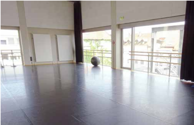
Fast optimaler Tanzboden. Lediglich die Verklebungen können Stolperstellen darstellen und müssen regelmäßig erneuert werden
