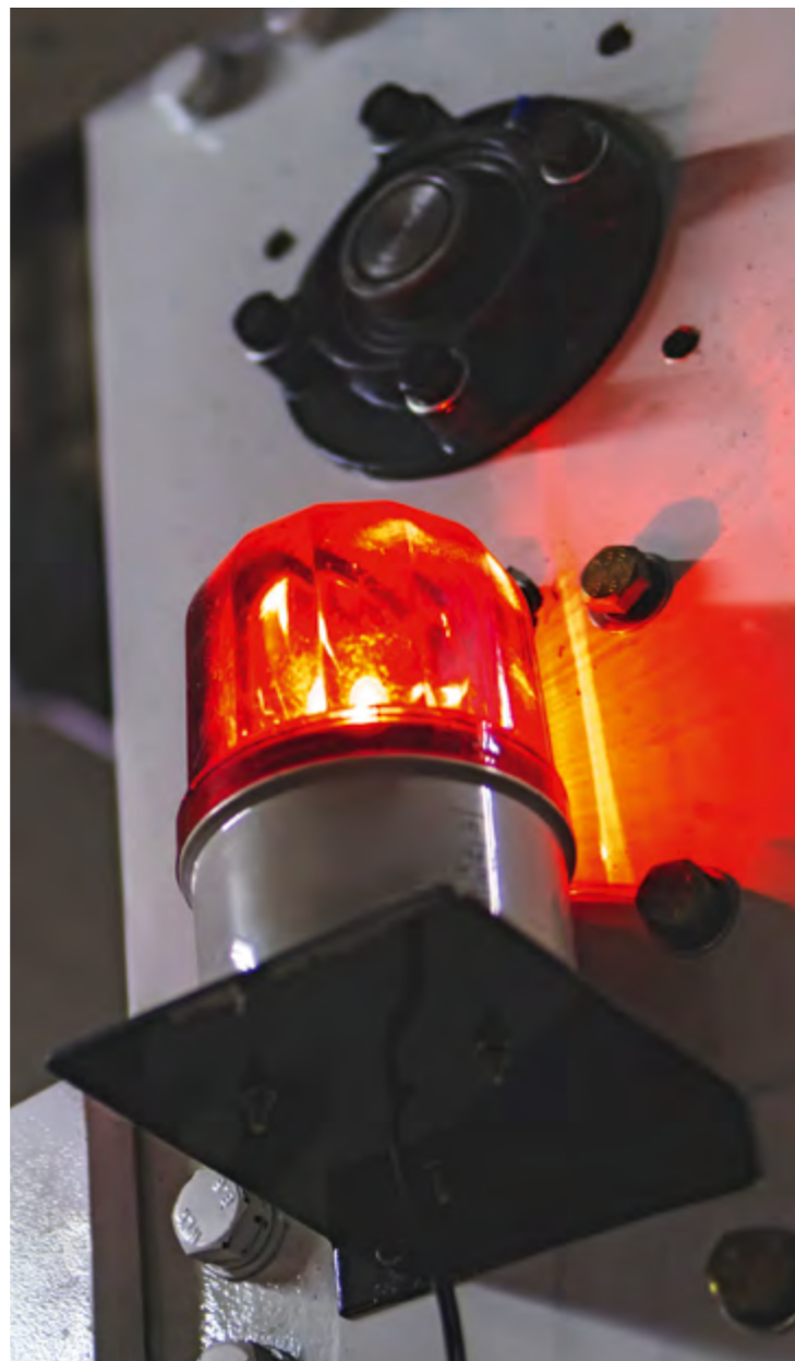
Zwei-Sinne-Prinzip: visuelle und akustische Alarmsignale im Brandfall.
